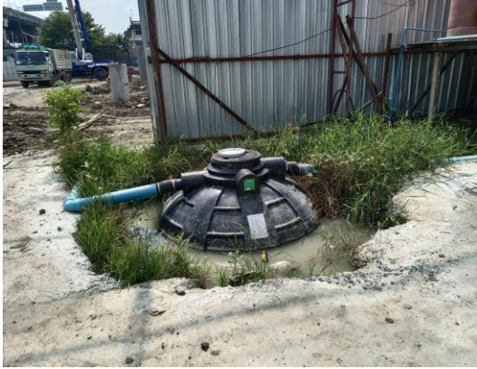
รูปที่ 19 ระบบบำบัดน้ำเสียสำเร็จรูปช่วงก่อสร้าง
