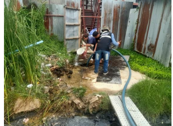
รูปที่ 36 สูดกากตะกอน
