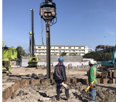
รูปที่ 30 การกดเสาเข็มแบบ Jack In Piling
