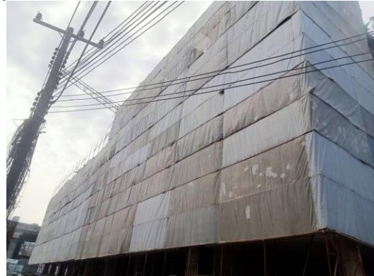
รูปที่ 28 ตาข่ายกันฝุ่นรอบตัวอาคารโครงการ
