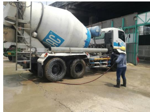
รูปที่ 24 การฉีดพรมล้อรถก่อนออกนอกพื้นที่โครงการ
